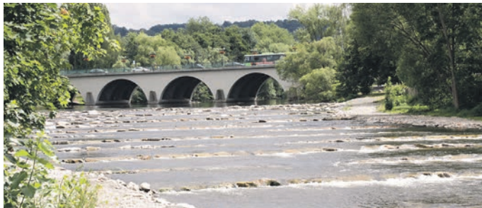
Die Sohlgleiten am ehemaligen Zeisswehr in Saalfeld, die am 9. Juli zum Abschluss des Umbaus vom Thüringer Landesamt für Umwelt, Bergbau und Naturschutz eingeweiht wurden. (Foto: Martin Modes)
