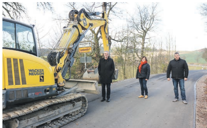
Landrat Marko Wolfram, Tiefbau-Sachbearbeiterin Annett Karlen und Mike Schüler, Geschäftsführer Bickhardt Bau Thüringen, am Tag der Fertigstellung. (Foto: Peter Laham)
