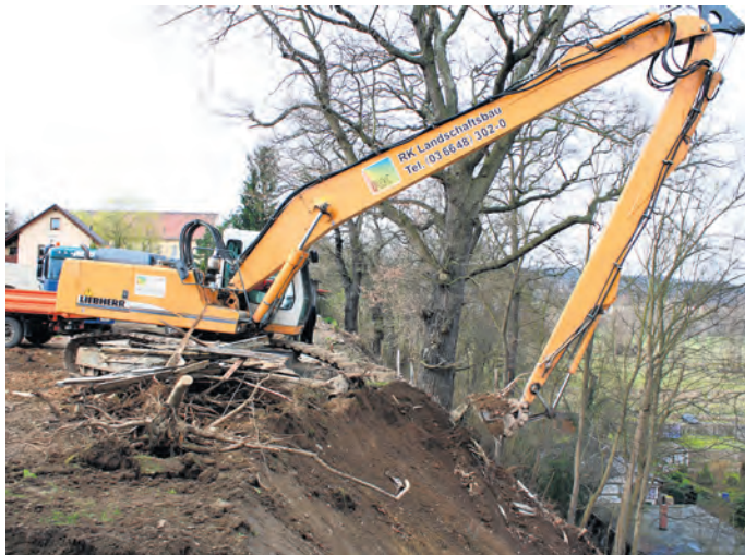
Ein Langarmbagger der beauftragten Firma beim Wiederherstellen des Hanges
